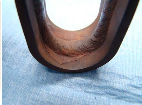
(d) Compressive side of U-bend after exposure
