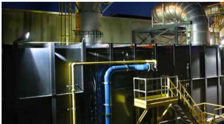
Figure 3-8. B&W Thermal Oxidizer
