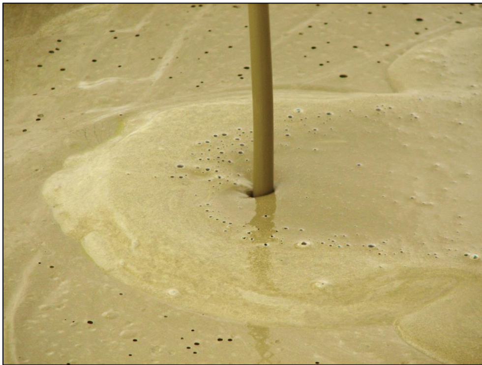
Figure 3-6. Grout slurry pour stream.
